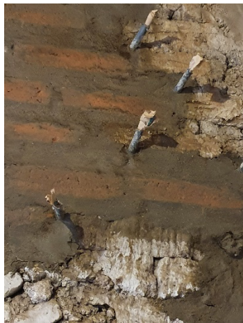
Figura 18 Imagen de mampostería humedecida con mucilago para recibir el mortero
