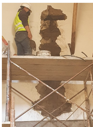
Figura 13 Imagen del proceso de cosido de fisura
