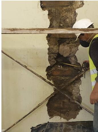
Imagen del proceso de descosido y cosido de la mampostería afectada
